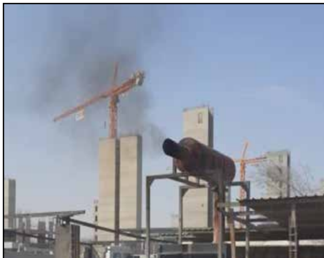
Vor der Installation der micfil Filter.
