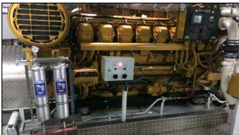
AL600 Doppelsystem für Öl an einem Generator.
