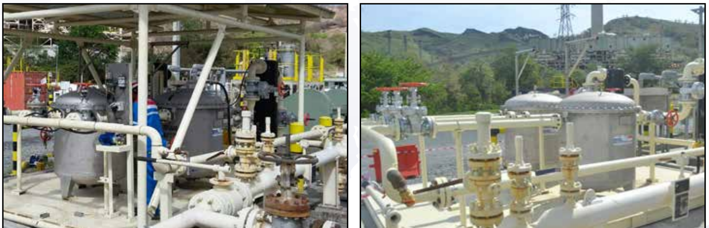
Wechsel der 1 µm High-Flow-Filtereinsätze HF900 nach 16.000.000 l.
